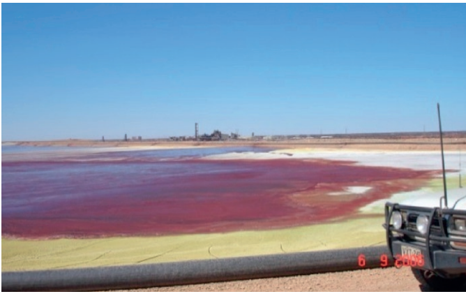
Fig. 8. Tailings storage (Tailings pond) of Olympic Dam (BHP Billiton). Bild 8. Rückstandsspeicher (Tailings pond) von Olympic Dam (BHP Billiton). Photo/Foto: Lersow
